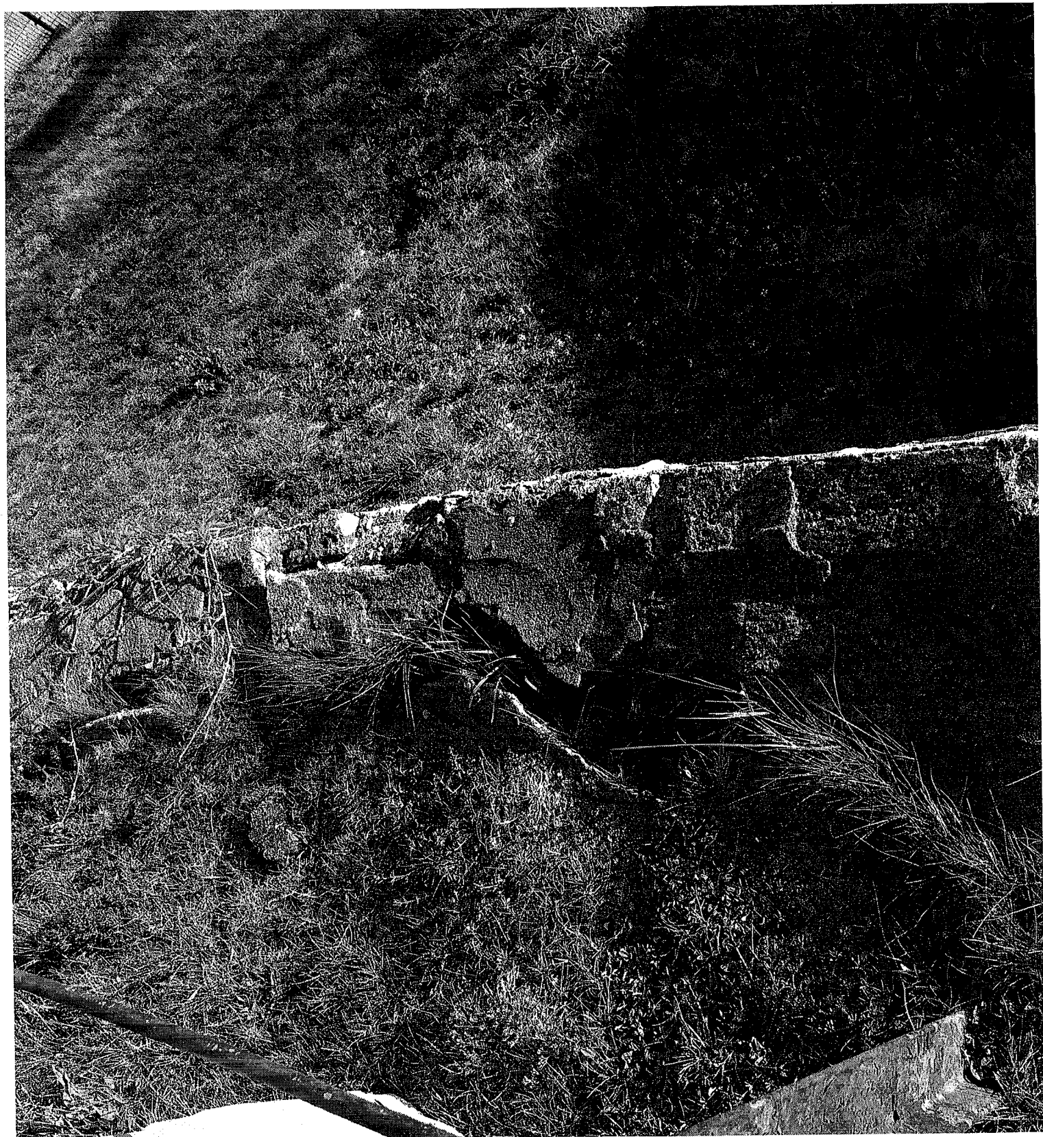
Zdjęcie 2 - mur oporowy to tylko kamienie z fugą cementową, jego pęknięcia stale się powiększają.
